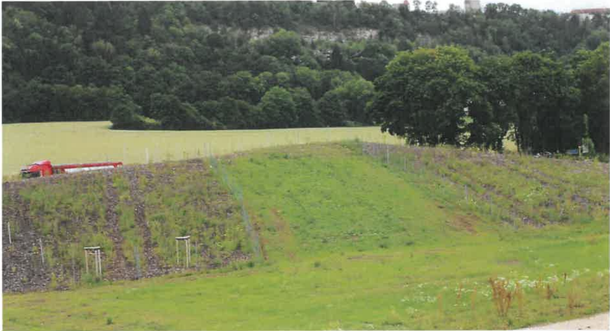
Abbildung 11: Bestandsvegetation zum aktuellen Zeitpunkt (Eigene Aufnahme 02.07.2021)
